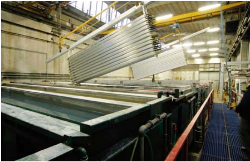
7 - Vista dell'impianto d'ossidazione anodica utilizzato anche per il pretrattamento alla verniciatura.
