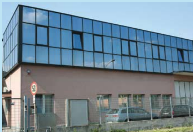
A - La sede dell'Aluservice e dell'Aluengineering a Lainate (Mi).
